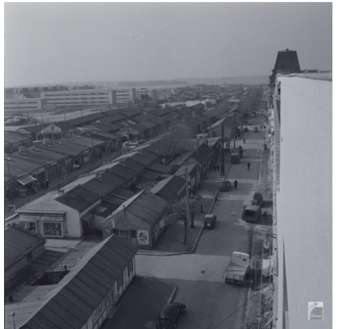
La cité commerciale en baraques de la place Jules Ferry au début de la Reconstruction, vers 1955
