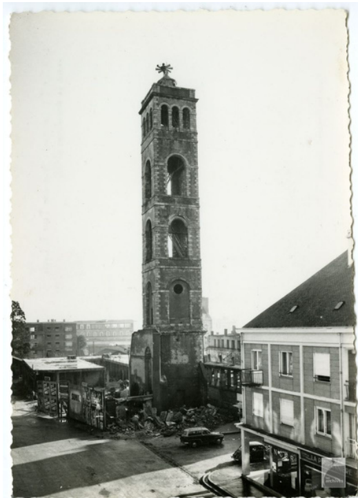
La tour de l'ancienne église Saint-Louis avant sa démolition, en haut de la tour, une sirène de la défense passive, vers 1957
